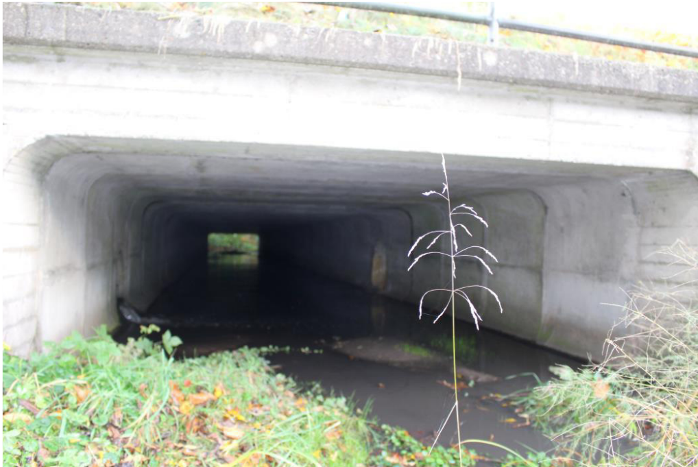
Abbildung 4-10: Bestandsdurchlass der Rethenbek an der B73
