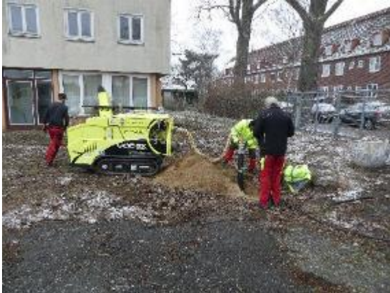
Erstellung des Wurzelsuchgrabens (Beispiel) Foto erstellt durch Eckhard Zemke
