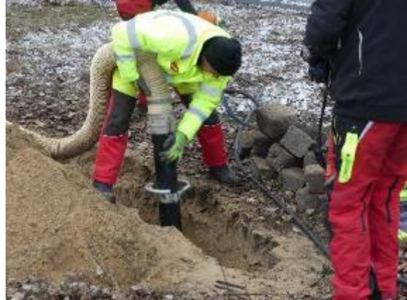
Saugschlauch im Graben (Beispiel) Foto erstellt durch Eckhard Zemke
