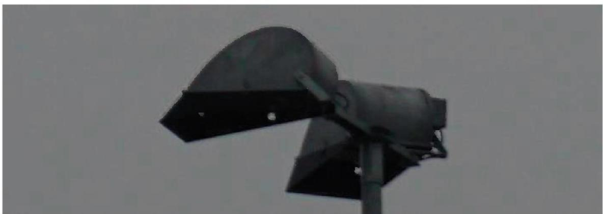
Abbildung 2: Installierte Leuchten PSH 2100 BE mit Blende
