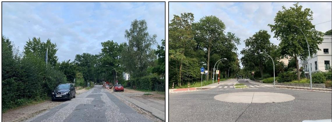
Abbildung 16: Sülldorfer Kirchenweg (links: schmale Fahrbahn, Straßenschäden, schmale / nicht definierte Seitenräume; rechts: ausgebauter südlicher Straßenabschnitt)
