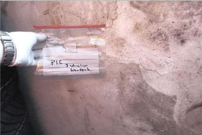
5. OG Außenwand, Innenputz (Probe P 15: Asbest n.n.)
