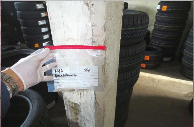
5. OG, Stützen, Spachtelmassen (Probe P 16: Asbest n.n.)
