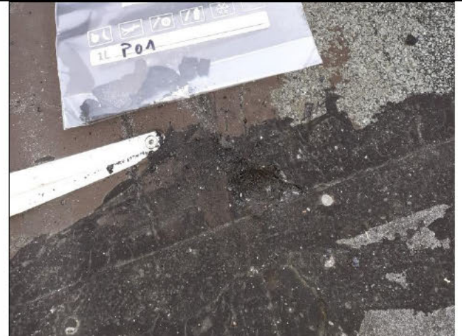
Nr. 144, Schuppen (Rent a Bike): Dachpappe → P 01
