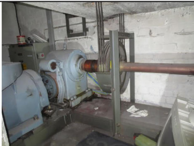
Nr. 144, KG: Fahrstuhl Antrieb
