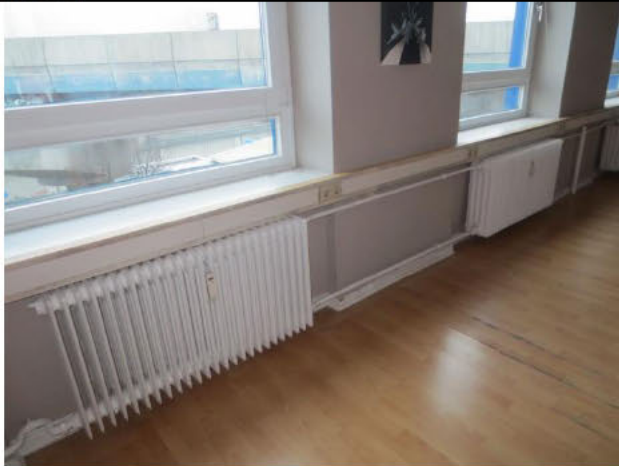
Nr. 144, 4. OG Nordseite: Innenausbau
