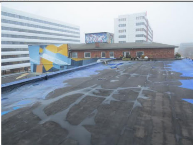
Nr. 144, Dach über 4. OG mit Blick nach Westen
