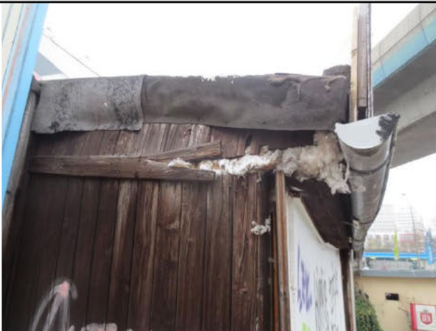
Nr. 144, Schuppen (Rent a Bike): Isolierung Dach
