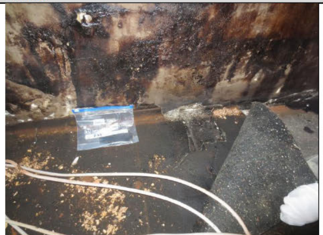
Nr. 140, altes UG: Boden Bitumen Belag → P 47
