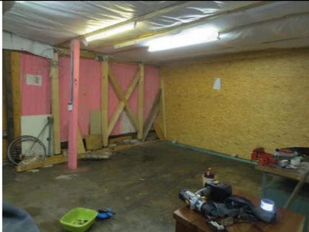
Nr. 144, Schuppen (Rent a Bike): Innenausbau Raum 1
