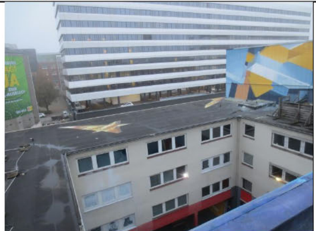
Nr. 144, Dach über 4. OG mit< blick nach Süden
