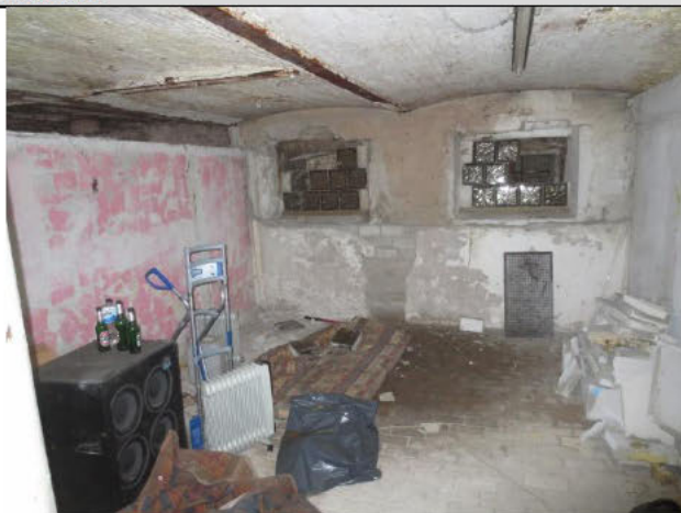
Nr. 140, altes UG: Kellerräume
