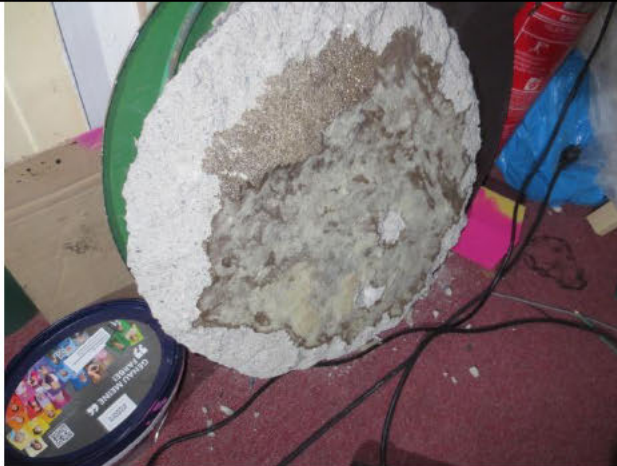
Nr. 144, 1. OG Deckendurchbruch mit Dämmmaterial
