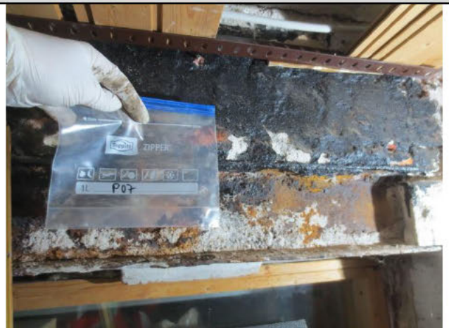
Nr. 140, Anbau: Souterrain, Schutzanstrich Stahlträger → P 07
