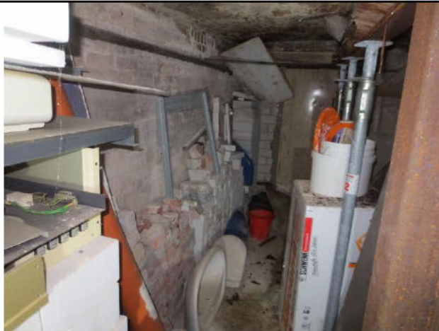
Nr. 140, Anbau: Innenausbau UG
