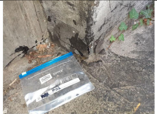
Nr. 144, Schuppen (Rent a Bike): Sockeldichtung → P 02
