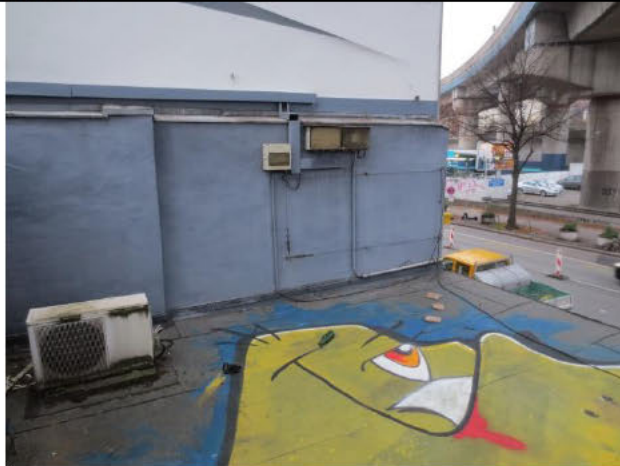
Nr. 140, Anbau: Dach mit Blick auf Spaldingstr.
