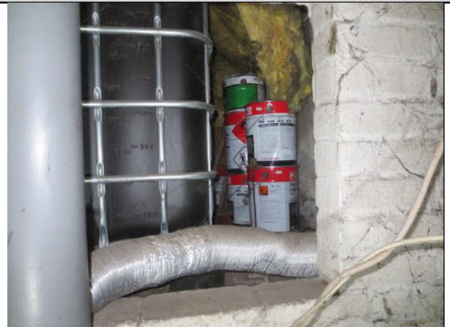
Nr. 140, altes UG: Mineralwolle Dämmung Außenwand
