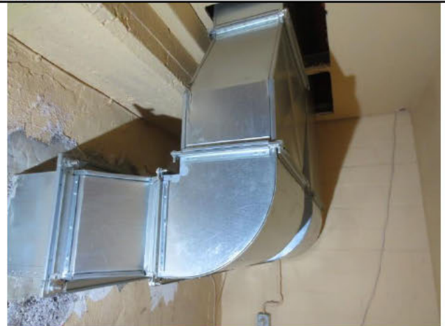
Nr. 144, KG: Durchführung Lüftungskanal
