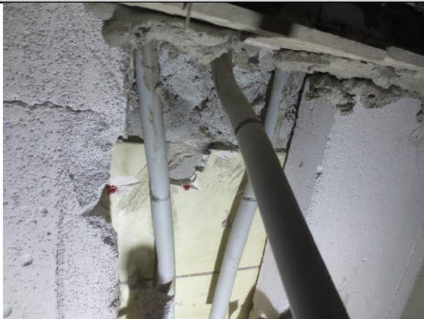
Nr. 144, 4. OG Sanitärraum: alter Fliesenspiegel
