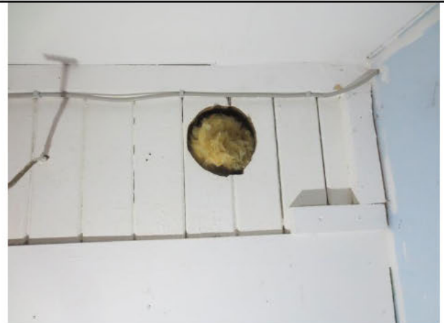
Nr. 144, Schuppen (Rent a Bike): Isolierung Innenwand
