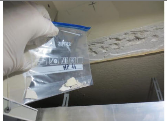
Nr. 144, EG Innenwand: Putz → P 16
