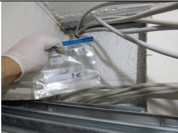
Nr. 144, EG Außenwand: Strukturputz → P 15
