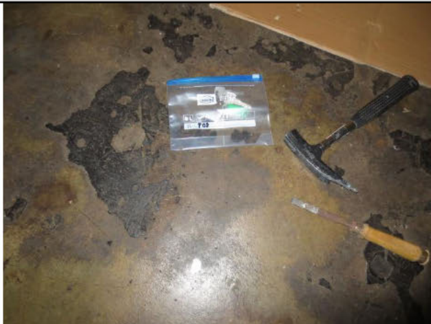
Nr. 144, Schuppen (Rent a Bike): Fußbodenbelag → P 08
