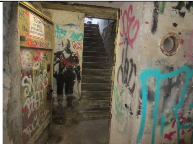
Nr. 140, altes UG: Treppenabgang und FH-Tür
