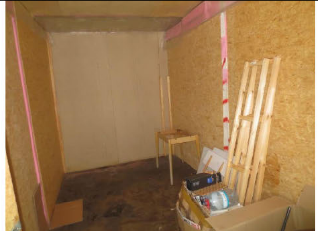
Nr. 144, Schuppen (Rent a Bike): Innenausbau Raum 2
