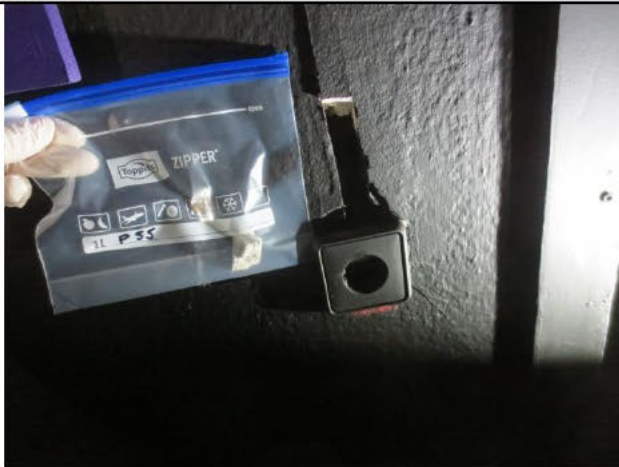
Nr. 144, 3. OG Innenwand: Spachtelmasse → P 55
