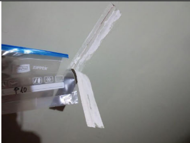
Nr. 144, Schuppen (Rent a Bike): Decke Spachtelmasse → P 10
