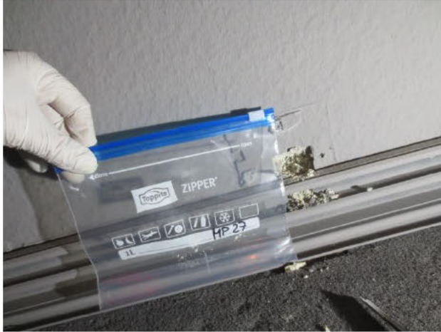
Nr. 144, 1. OG Südtrakt: Wandputz → P 27
