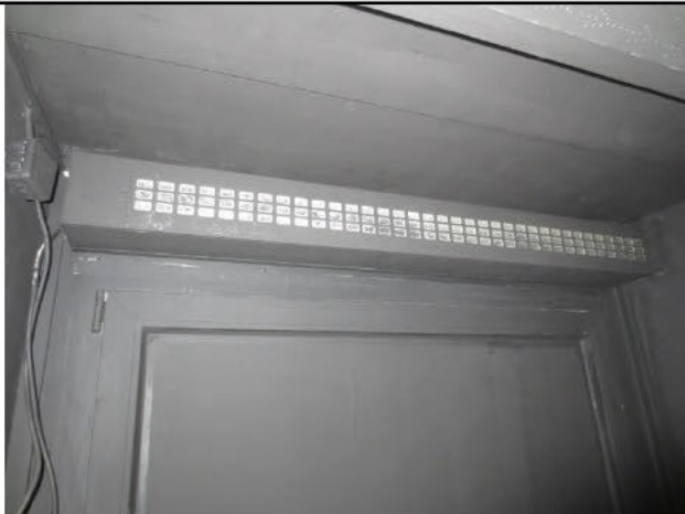
Nr. 144, EG Außenwand: Rolladenkasten
