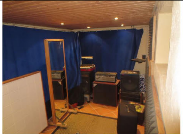
Nr. 140, Anbau: Innenausbau Souterrain, Raum 1
