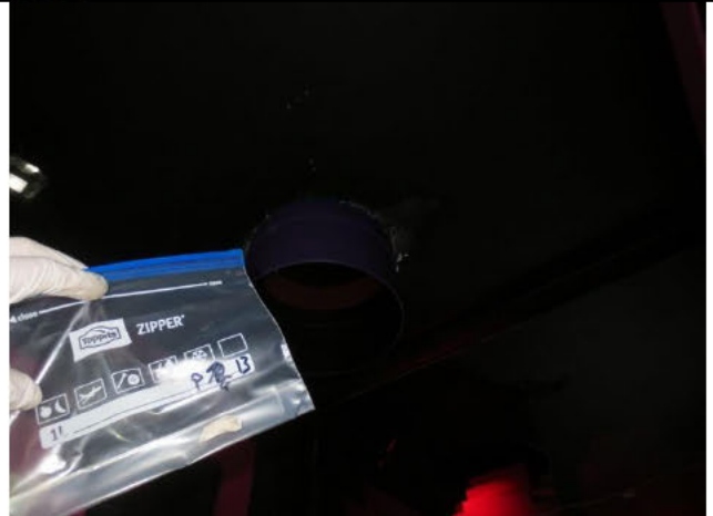
Nr. 144, Eingangsbereich Spaldingstr.: Decke → P 13
