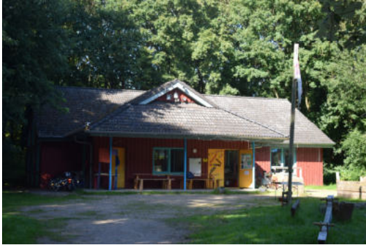
Abb. XX: Teilfläche FLB Gebäude B4
