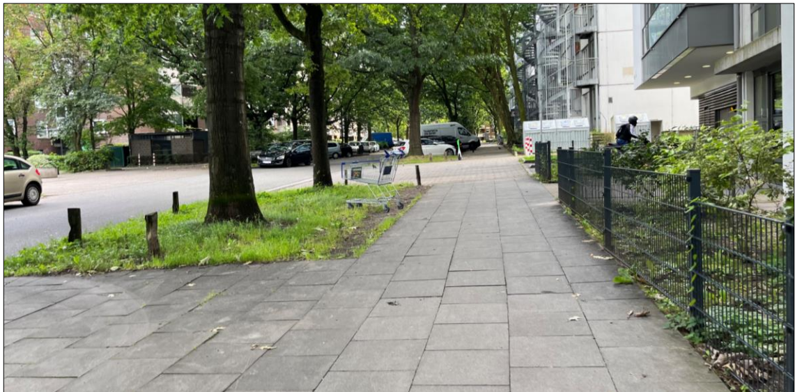
Abbildung 4: Gehwegbereich am Gropiusring (Breite ca. 3,75 m, zzgl. Grünflächen – eigene Aufnahme)
