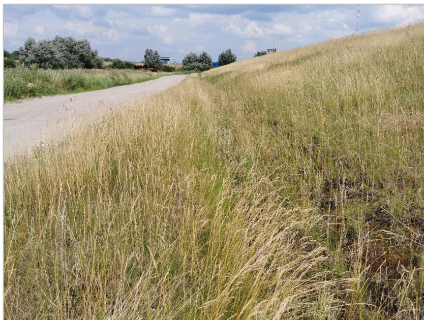
Abb. 3: Entwässerungsmulde im Westen der Deponie mit einzelnen Exemplaren des Drüsiges Weidenröschens
