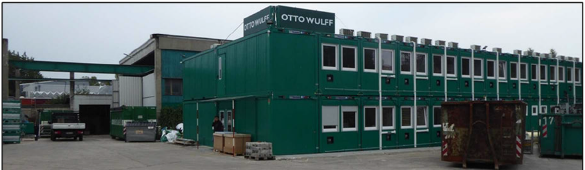
Abbildung 10: Bürocontainer H; im Hintergrund Halle F (03.09.2020)
