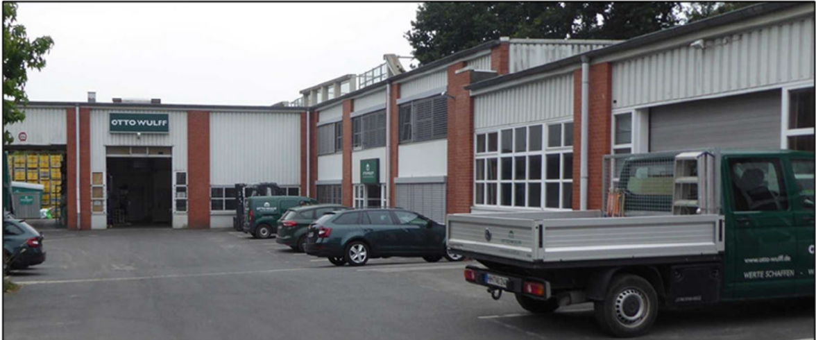
Abbildung 7: Außenansicht der Werkstätten (03.09.2020)
