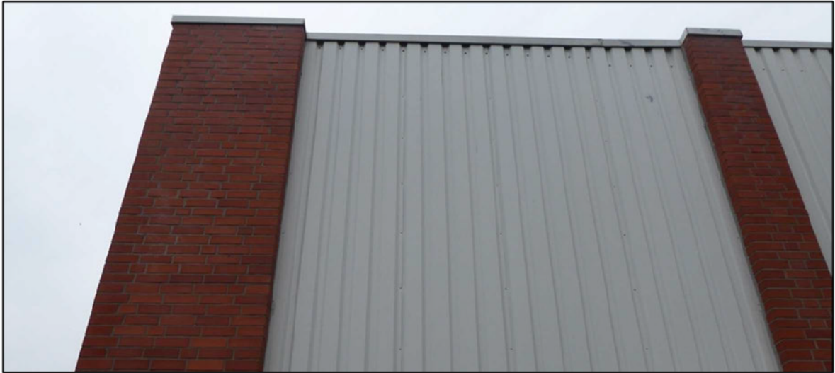
Abbildung 5: Fassade der Halle F, Einschichtige Wand ohne Verkleidungen (03.09.2020)
