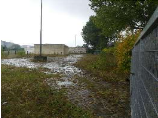
Betriebshof mit Granitgroßpflaster
