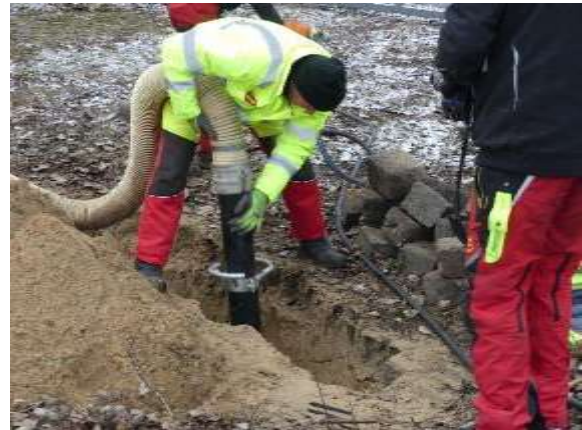
Saugschlauch im Graben (Beispiel)
