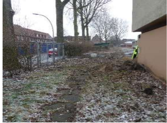
Graben neben Bestandsbau
