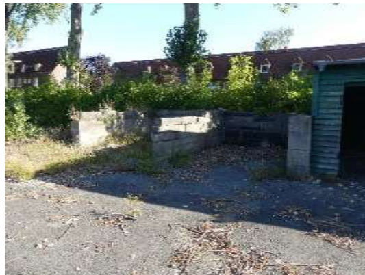
Versiegelung bis an Grundstücksgrenze
