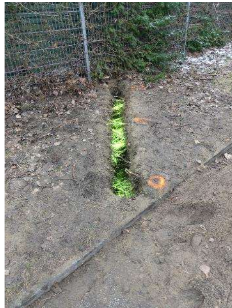
Graben mit markiertem Wurzelwerk
