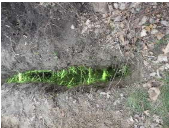
Graben mit markiertem Wurzelwerk
