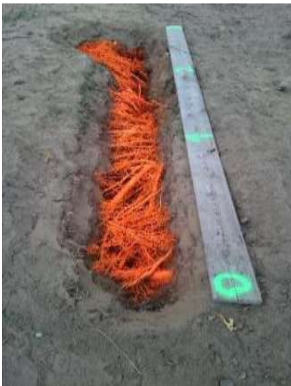
Wurzelsuchgraben mit markierten Wurzeln (Beispiel)
