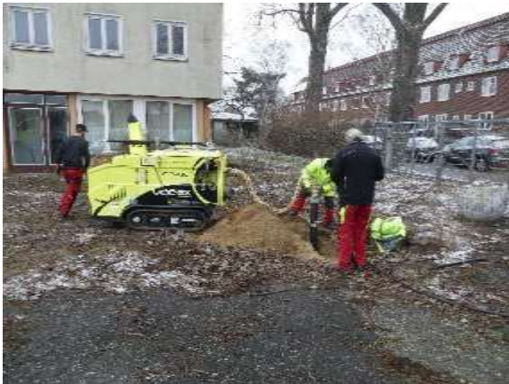
Erstellung des Wurzelsuchgrabens (Beispiel)
