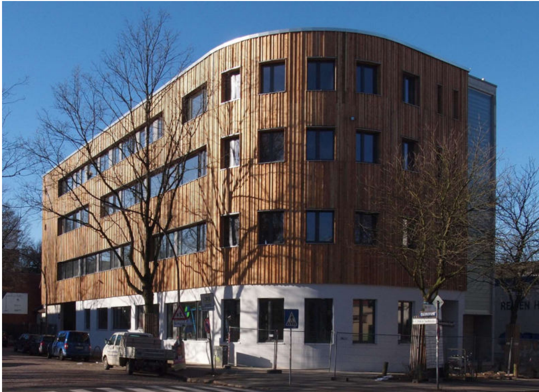
ABBILDUNG 18: MEHRGESCHOSSIGER HANDWERKERHOF IN HAMBURG-OTTENSEN
