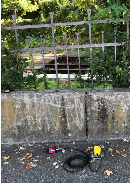
Messpunkt MP1 – Ansicht mit U-Bahngleis
