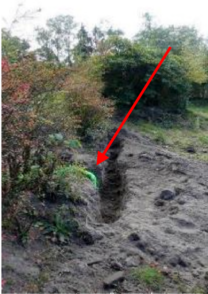
Abknickend am ehemaligen Becken
