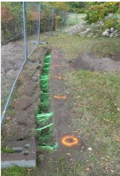
Graben mit markierten Wurzeln
