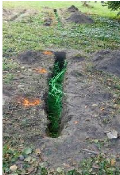
Graben mit markierten Wurzeln
