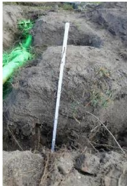
Tiefe der Grabung
