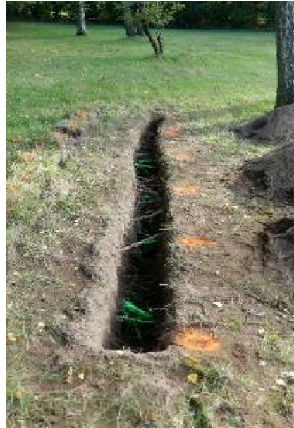
Graben mit markierten Eichenwurzeln
