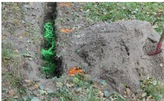
Graben mit markierten Wurzeln
