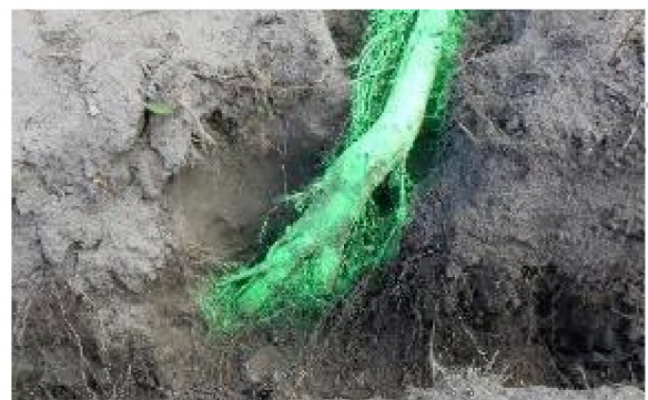
Abknickend am ehemaligen Becken
