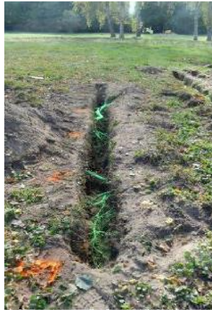
Graben mit markierten Wurzeln
