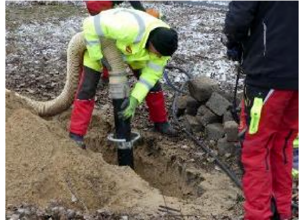
Saugschlauch im Graben (Beispiel)
