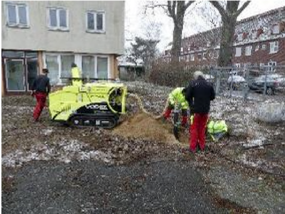
Erstellung des Wurzelsuchgrabens (Beispiel)
