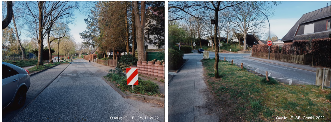
Abbildung 4: Zustand der Straße Wiesenredder im Bereich des Bauvorhabens (Stand: 04/2022)
