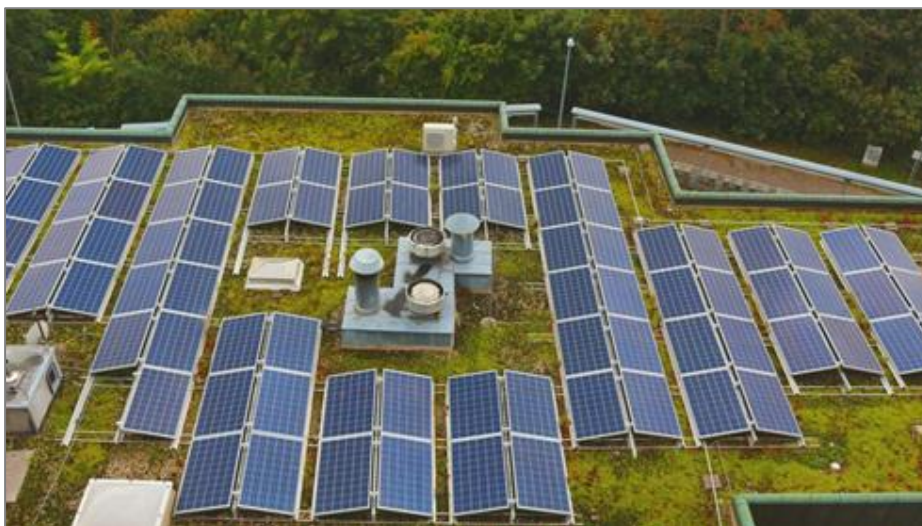
Abbildung 7: Gründach mit Photovoltaik als Ost-West System (Sattel) 6
