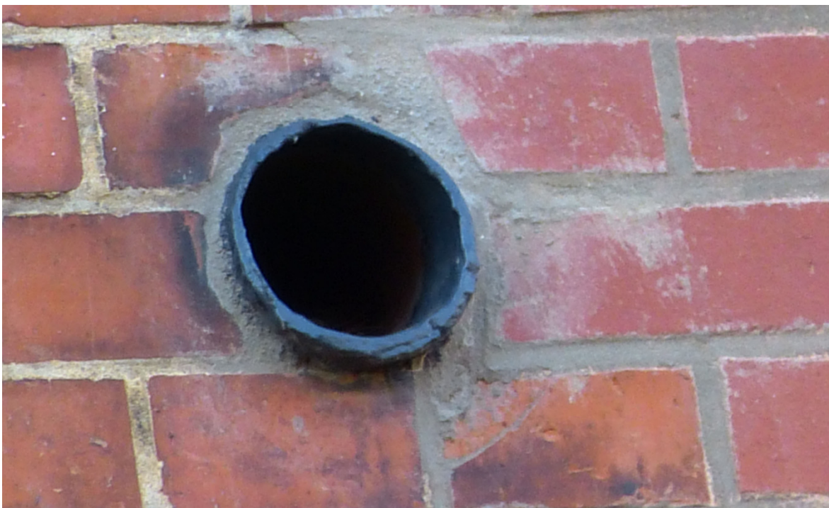
Abbildung 4-4: Detailbild der Röhre an Südseite des Speichers V (Foto: M. Haacks)
