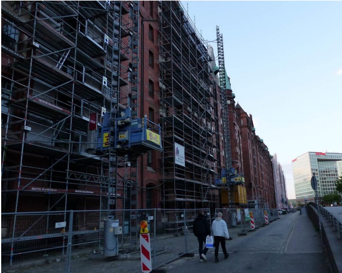
Abbildung 4-5: Eingerüstete südöstliche Außenfassaden der Speicherblöcke V und X (Foto: M. Haacks)
