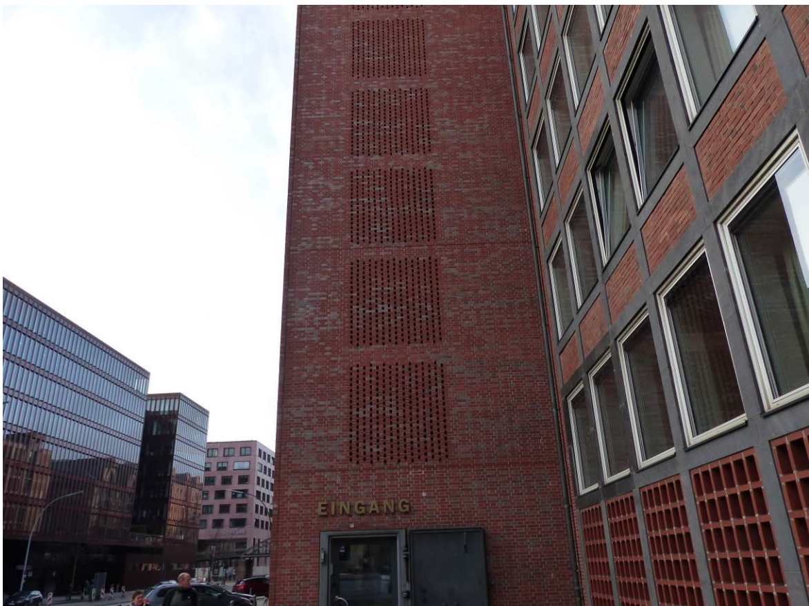
Abbildung 4-7: Östliche Parkhausfassade mit Klinkerlöchern als wichtiger Brutplatz für den Haussperling (Foto: M. Haacks)
