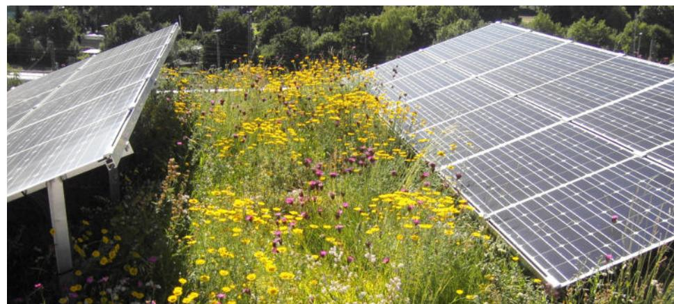
Abb. 54: Extensives Gründach mit kombinierter Energiegewinnung
