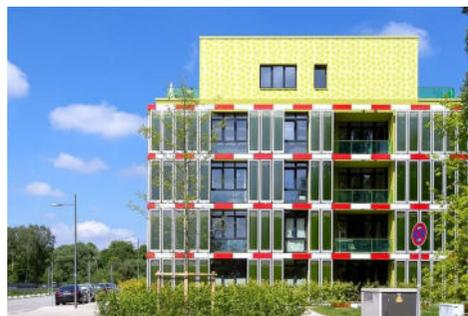
Abb. 125: Bioenergiefassade mit Mikroalgen (Splitterwerk Architekten, IBA Hamburg)
