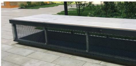
Abb. 116: Sitzelement mit seitlicher Lüftungsöffnung
