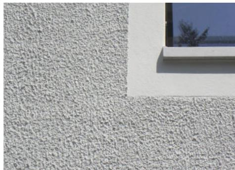
Abb. 29: Strukturierte Putzfassade auf massivem Ziegelbau
