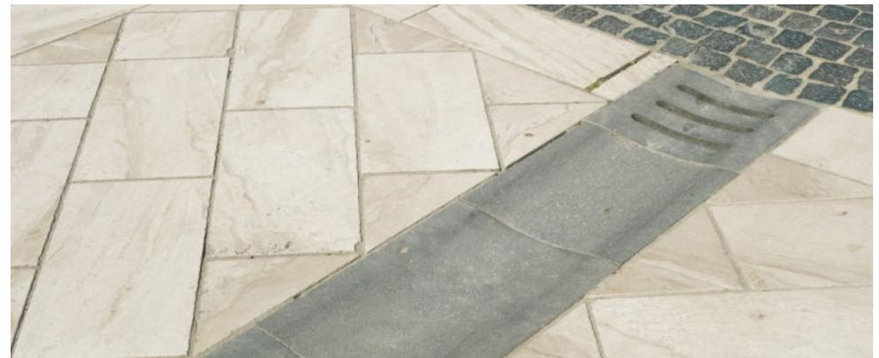
Abb. 107: Offene Entwässerung in hochwertigem Belag
