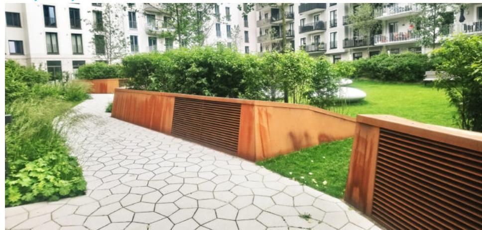
Abb. 119: Gestalterisch integrierte, begrünte Lüftungsöffnungen
