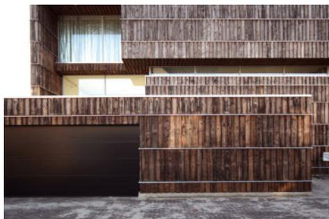
Abb. 124: Recyclingholz aus alten Kabeltrommeln als Fassadenmaterial (2012 Architekten)
