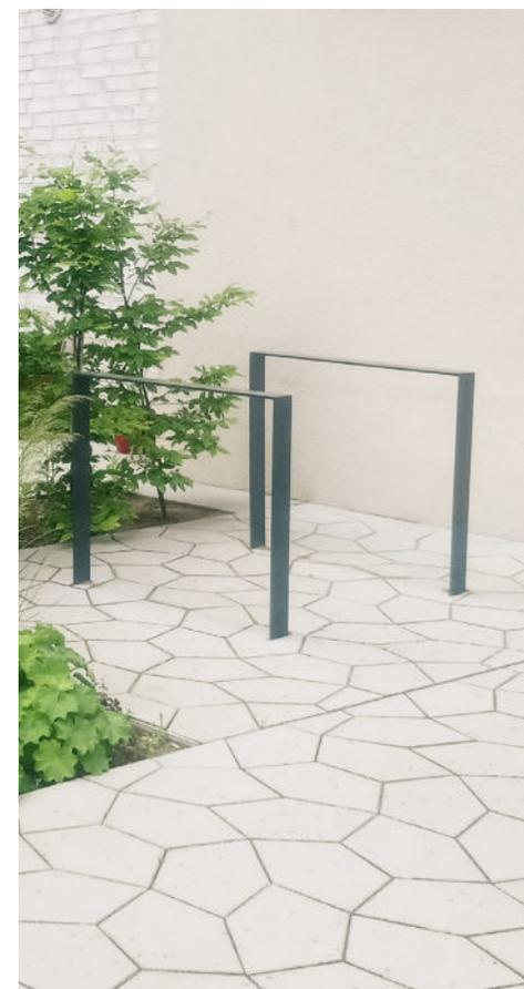
Abb. 113: Flachstahlfahrradbügel in Plattenbelag
