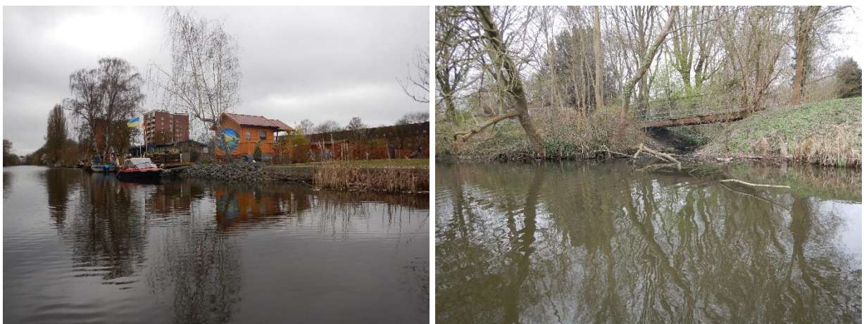
Abb. 13: Aßmannkanal mit Verbau im Bereich der Kleingartensiedlung mit Steinschüttung und Röhrichtbereichen (links). Totholzeintrag durch Uferbewuchs und Röhrichtgürtel (rechts) (Bildquelle: Planula 2022).
