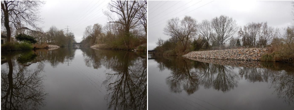
Abb. 10: Ernst-August-Kanal mit neu angelegter Steinschüttung (Bildquelle: Planula 2022).
