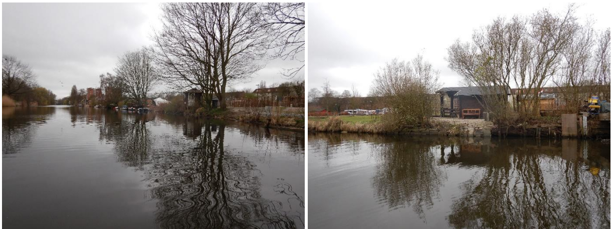
Abb. 12: Aßmannkanal mit Verbau im Bereich der Kleingartensiedlung (Bildquelle: Planula 2022).
