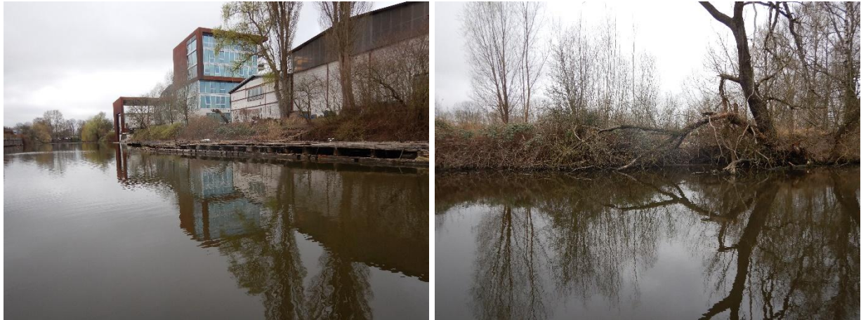
Abb. 15: Jaffe-Davids-Kanal mit Verbau im südlichen Bereich (links). Totholzeintrag durch Uferbewuchs (rechts) (Bildquelle: Planula 2022).
