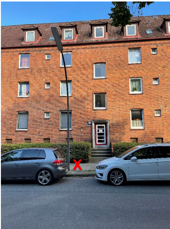
Messpunkt MP 18 , Zeidlerstr. 38
