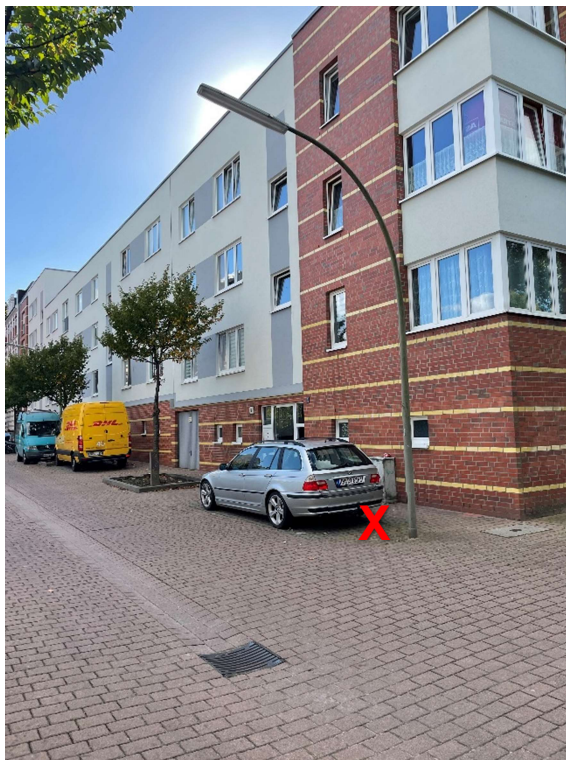
Messpunkt MP 25 , Schipperort 8 / Ecke Schutenort
