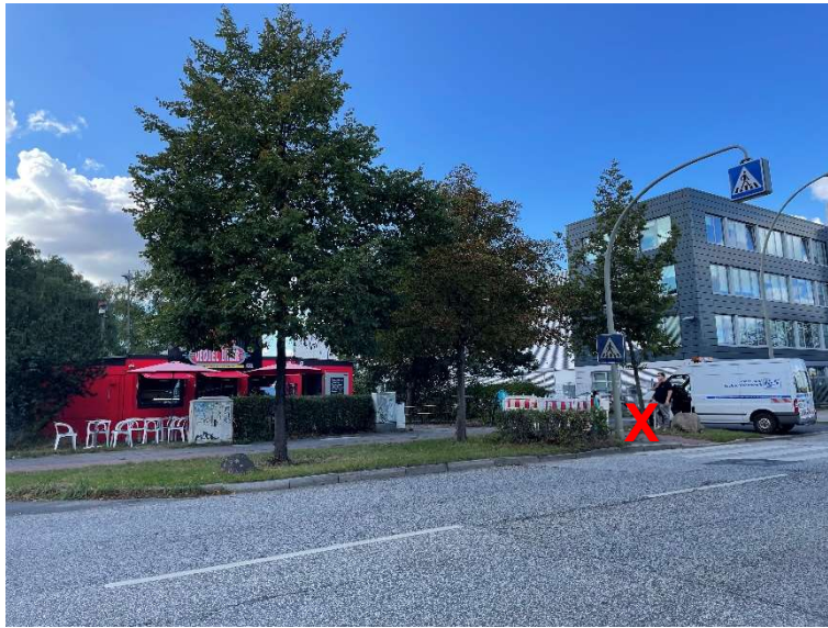
Messpunkt MP 28 , Schlenzigstr. 20
